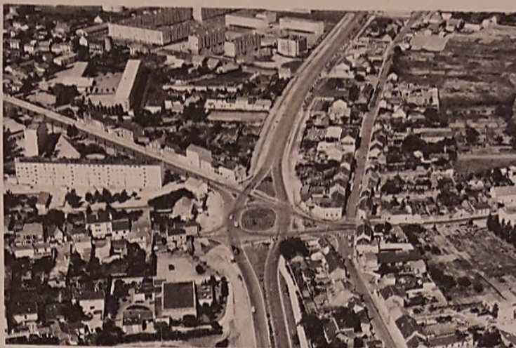
Premier tronçon de la liaison dite « Croix Bonneau » Gare maritime qui reliera les quartiers ouest de la ville au quai de la Fosse
