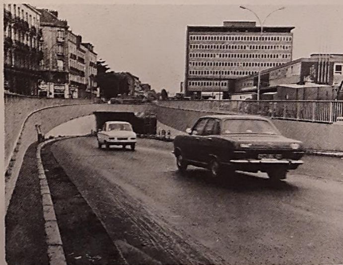
Un autre « point noir » de la circulation qui disparaît grâce à la mise en service de la trémie devant la gare
